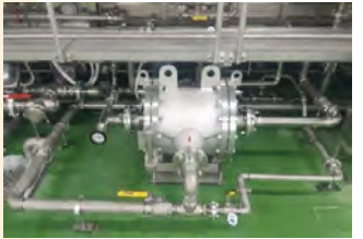
スパイラル式排熱回収装置 茹麺装置の排熱を回収し、重油の使用量を削減する装置。CO 2 排出削減に貢献
