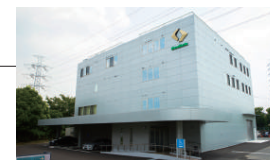
本社 第2棟 (研究棟)
