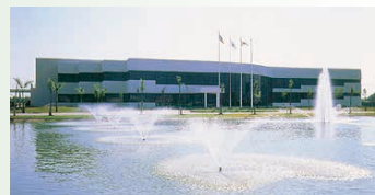
Sodick (Thailand) Co., Ltd.
