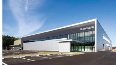
2 Sodick Kaga Factory
