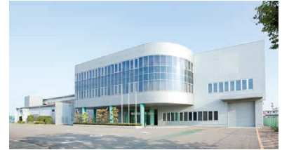
3 Sodick Fukui Office
