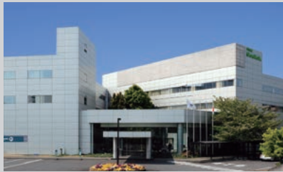
本社／技術・研修センター (神奈川県横浜市)
