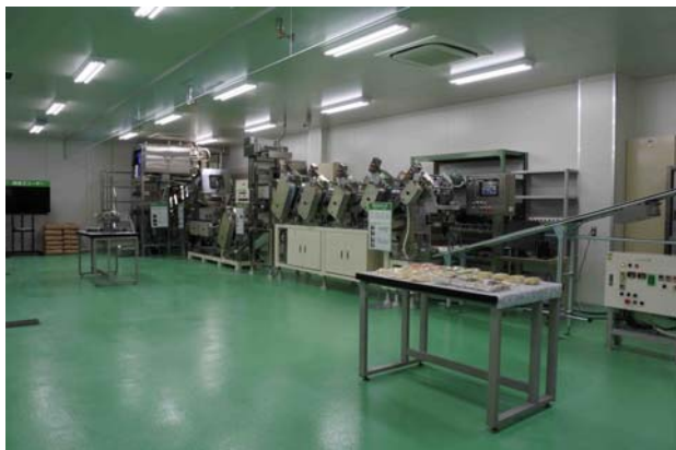
最新の製麺ラインを設置したショールーム
