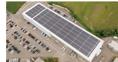
加賀事業所に設置した太陽光発電システム
