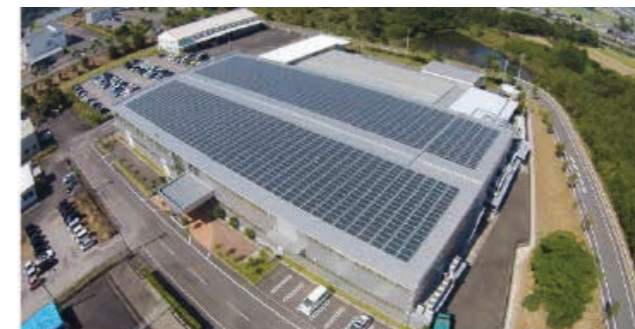
▲ ソディック エフ・ティ宮崎事業所 社屋屋上の太陽光発電システム
